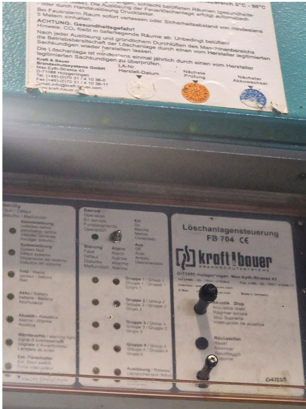
Bedien- und Anzeigeeinheit der Kraft &amp; Bauer Löschanlagensteuerung FB 704.
