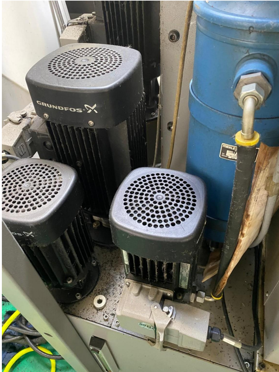
Pumpen- und Filteraggregate im Versorgungsbereich der Maschine.
