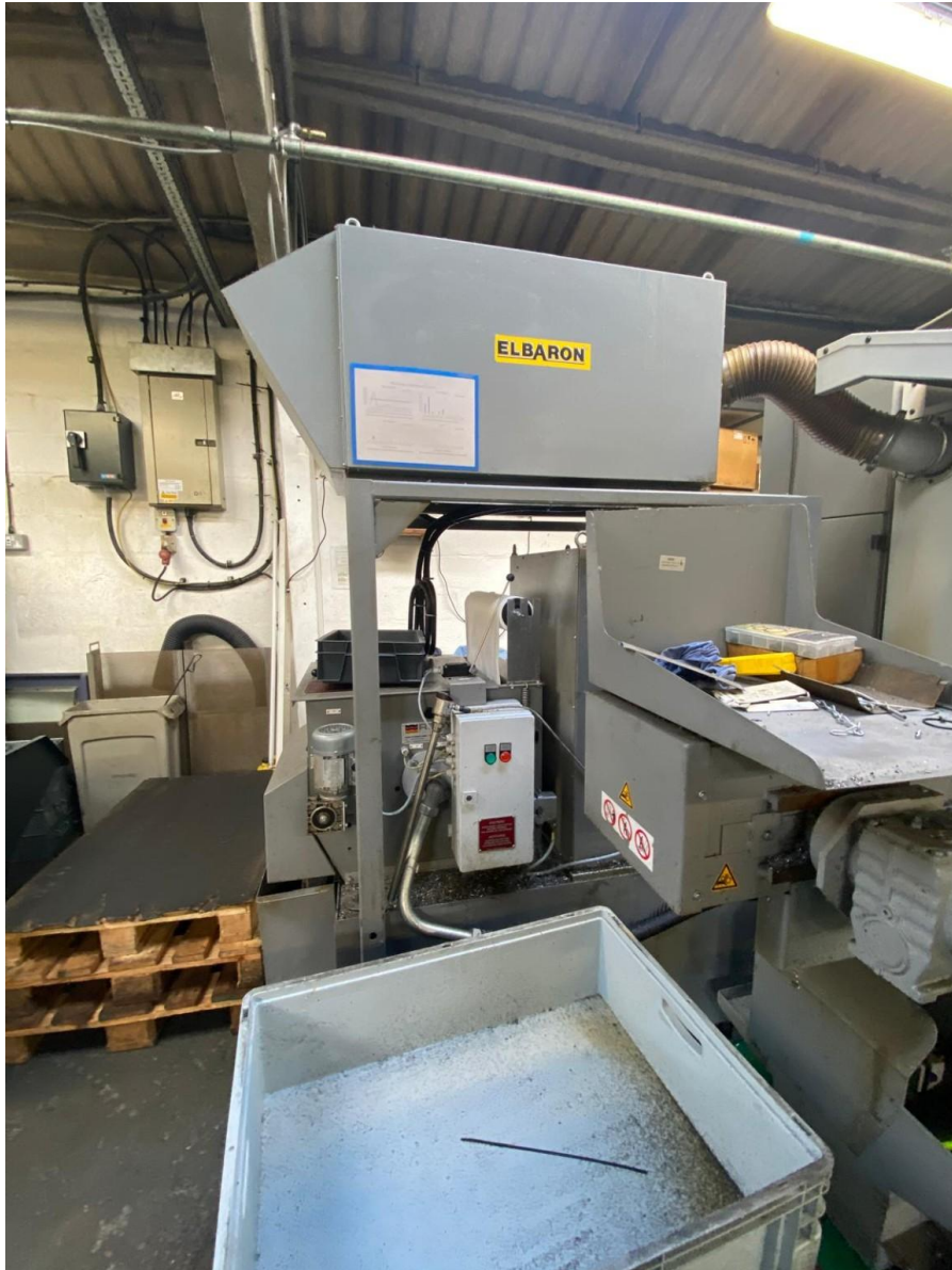
Gesamtansicht der rückseitigen Peripherie mit Späneförderer und Absauganlage ELBARON.
